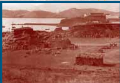
Chantier de la butte Conneau, 1875, coll. Bibliothèque Bernheim
