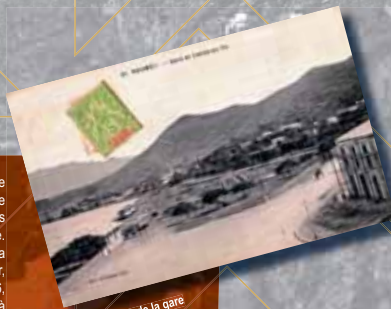
Construction de la gare de la vallée du Tir coll. MDVN
