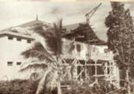
Construction du nouvel évêché, fonds Sud Pacific, coll. MDVN
