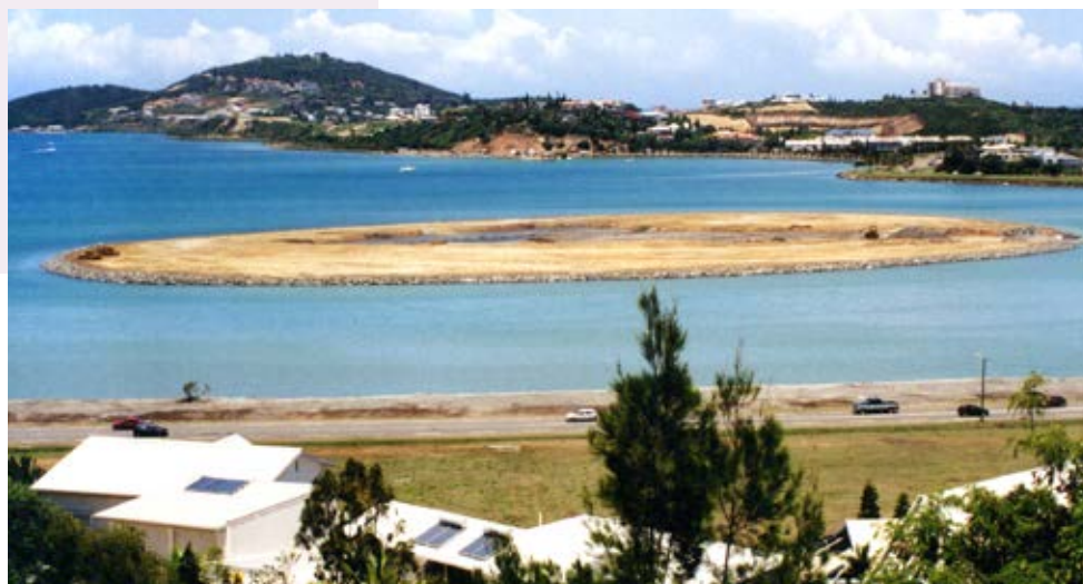
Travaux de remblaiement, en 2000.
