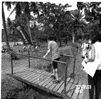
Installation de 3 rampes amovibles
