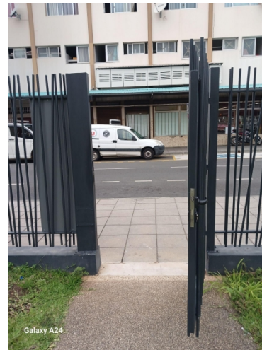
Portillon d'accès PMR
