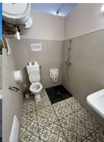
Ecole RUSSIER Création d'un sanitaire PMR
