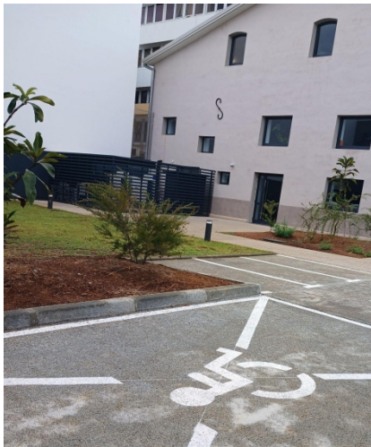
Place de stationnement PMR
