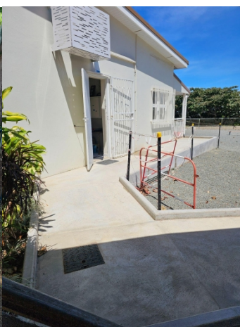
Ecole DUPONT Aménagement d'allées de circulation PMR
